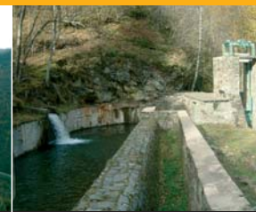
Pressa del Canal de Tegurà
